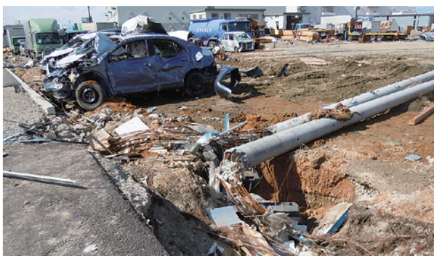
電柱が無残に折れた
