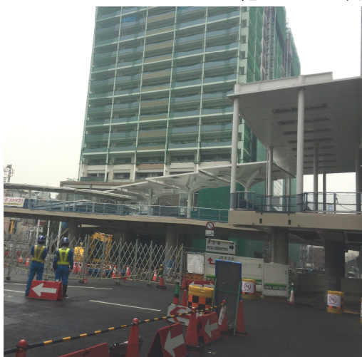
京急蒲田西口再開発建設中
